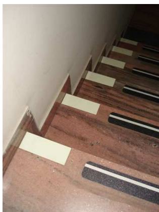
Figura 052 – Exemplo de um piso fotoluminescente e faixa antiderrapante
